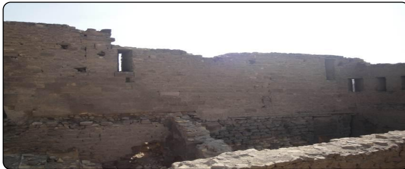
لوحة (٧) الواجهة الجنوبية الشرقية للخانقاه النظامية من الداخل (تصوير الباحث)
