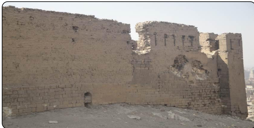
لوحة (١٠) الواجهة الشمالية الشرقية للخانقاه النظامية من الخارج (تصوير الباحث)
