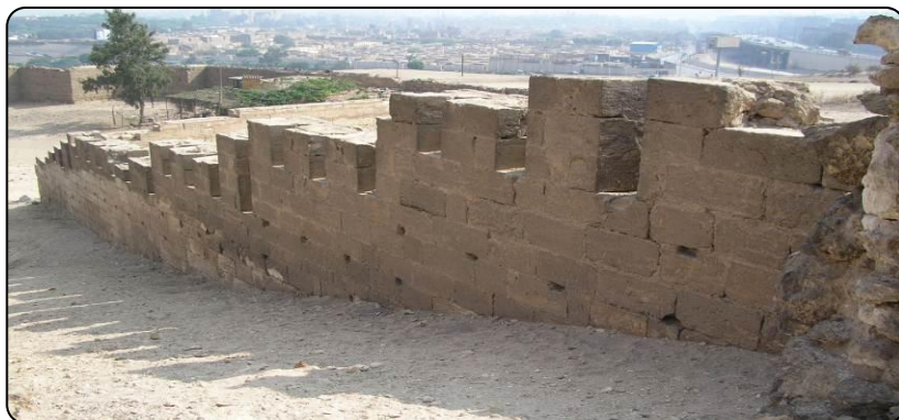
لوحة (١٤) مزاعل بنادق بالسور رقم (٣) من الداخل ضمن السور الممتد بين برج الصحرا (البرج الأحمر) بالسور الشمالي للساحة الشمالية الشرقية لقلعة صلاح الدين الأيوبي والواجهة الشمالية الشرقية للخانقاه النظامية (تصوير الباحث)
