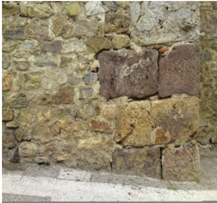
صورة ٠٣ :تقنية الحجارة الكبيرة Opus Quadratum
