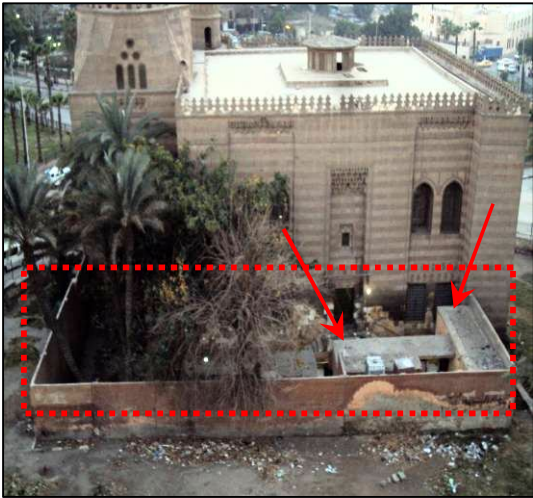
صورة رقم (١٦) : التعدادات على جامع المحمودية متمثلة في دورات المياه الموجودة خلف الواجهة الشمالية الشرقية .
