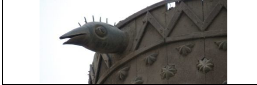
صورة رقم ١٠: تفصيل للميزاب للمزrab على شكل رأس طائر
