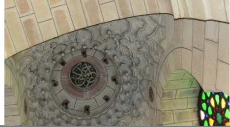
صورة رقم ٣٤: القبة والنافذة الجنوبية الشرقية للضريح.
