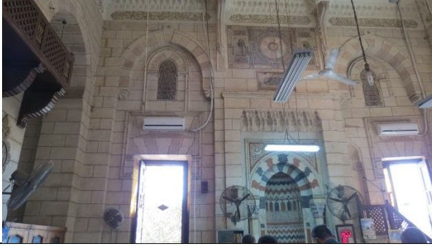
صورة رقم ٢٣: الجهة الجنوبية الشرقية وهي طبقة من مستويين ويوتر أعلى الجدران بحور كتابية وكورنيش مقرنص
