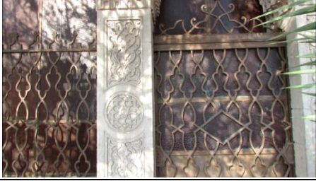
صورة رقم ١٤: الشبابتك الحديدية للواجهة الجنوبية.
