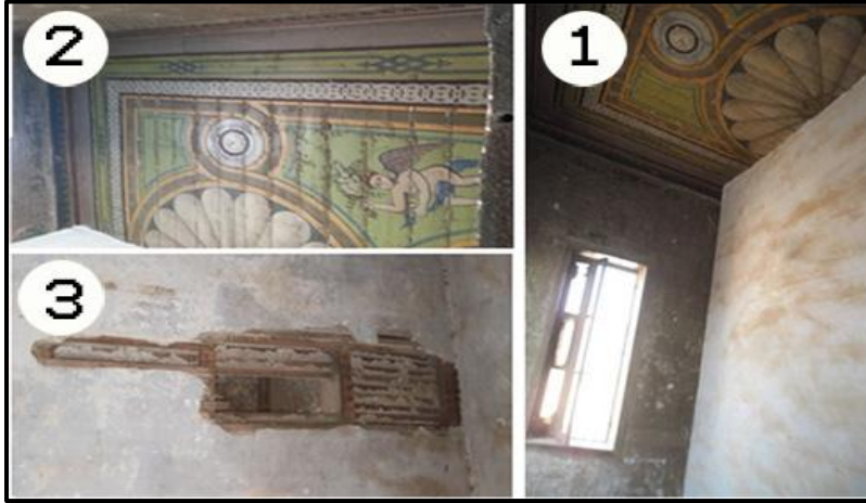
شكل (٤) ١- الأتربة وفقدان النوافذ ٢- الثقوب وفقدان طبقتي الشيد والزخارف ٣- ظهور ألواح الخشب البغدادي
