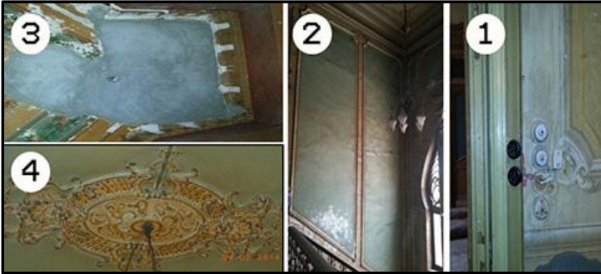
شكل (٢) ١- ظهور مفاتيح الكهرباء والأسلاك ٢- الأتربة على الجدران ٣- الاستكمال بالمونة الأسمنتية ٤- التأثير الحرارى على الزخارف
