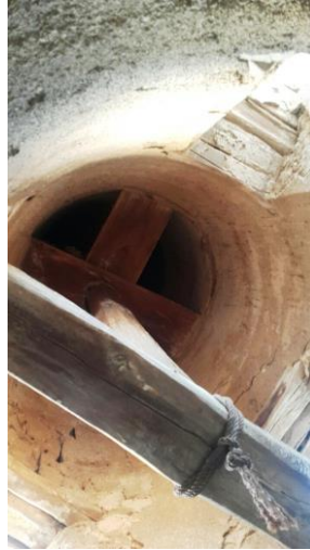
لوحة (٢٨-أ) مسجد الحنفي: تفاصيل للبراطيم الخشبية بالقسم العلوي للتجويف الداخلي للمئذنة (المستوى الثاني).
