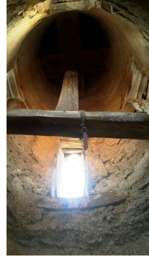
لوحة (٢٧) مسجد الحنفي: تفاصيل للبراطيم الخشبية بالقسم العلوي للتجويف الداخلي للمئذنة (المستوى الأول).
