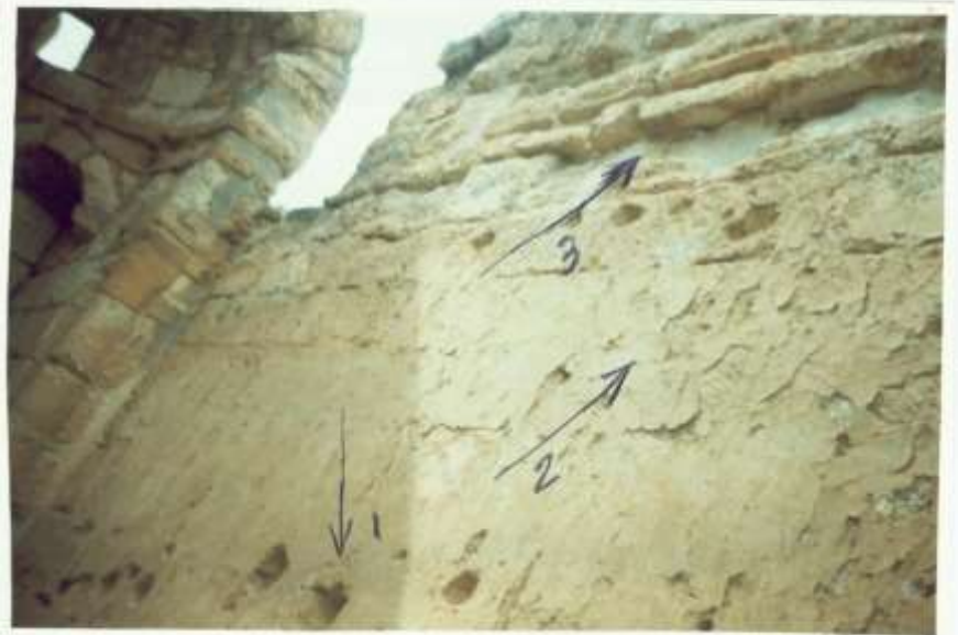
صورة (١٠) توضح تأثير عوامل التلف في تغير درجات الحرارة والرطوبة . وارتفاع نسبة الامطار على جدران قاعة العرش الداخليه .
