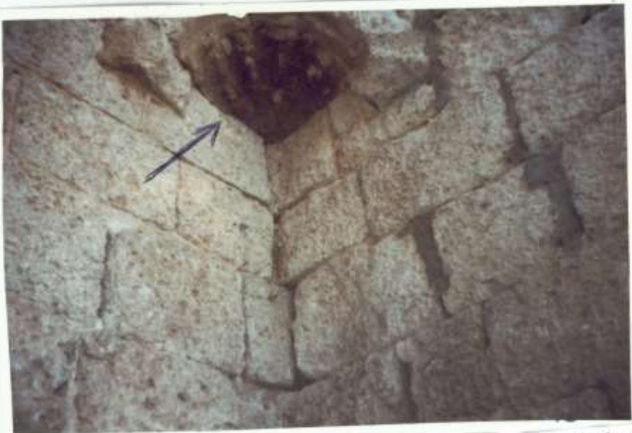
صورة (٦) توضح حنيه ركنية بمنطقة انتقال نصف قبة قاعة العرش وتأخذ شكل الخيارة .
