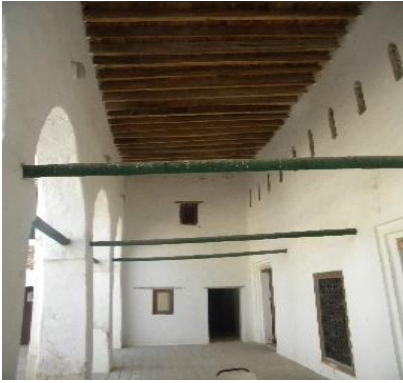
(لوحة ١٥) منزل الوادى الرواق الجنوبي للصحن ©تصوير الباحث.
