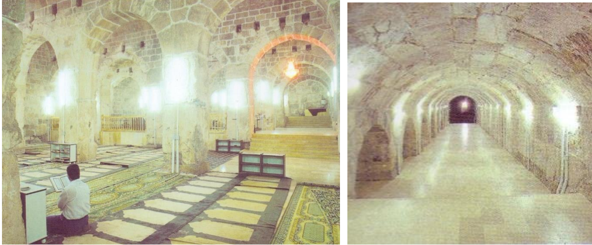
(لوحة ٤) توضح بناء ظلّة القبلة بالمسجد الأقصى على حوائط حاملة
