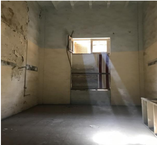
لوحة ٣٢) مكاتب القضاة بالطابق الثاني
