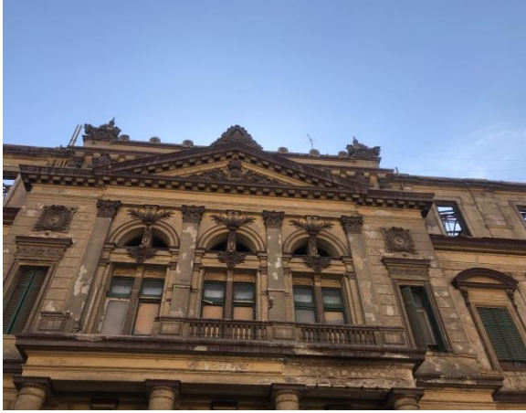
لوحة (٦) المستوى العلوي لكتلة المدخل بالواجهة الرئيسية
