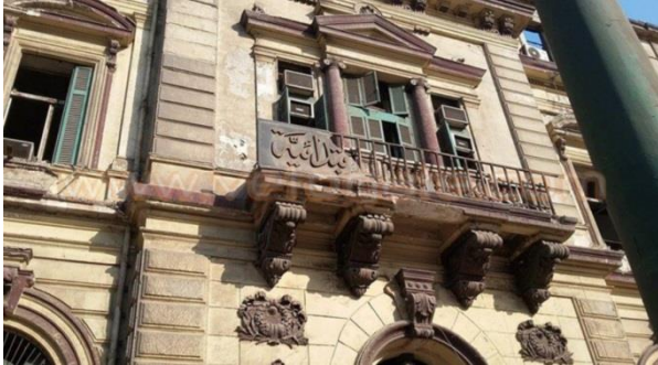
(لوحة ١٢) الشرفة الطائرة بكتلة المدخل الثاني للمحكمة
