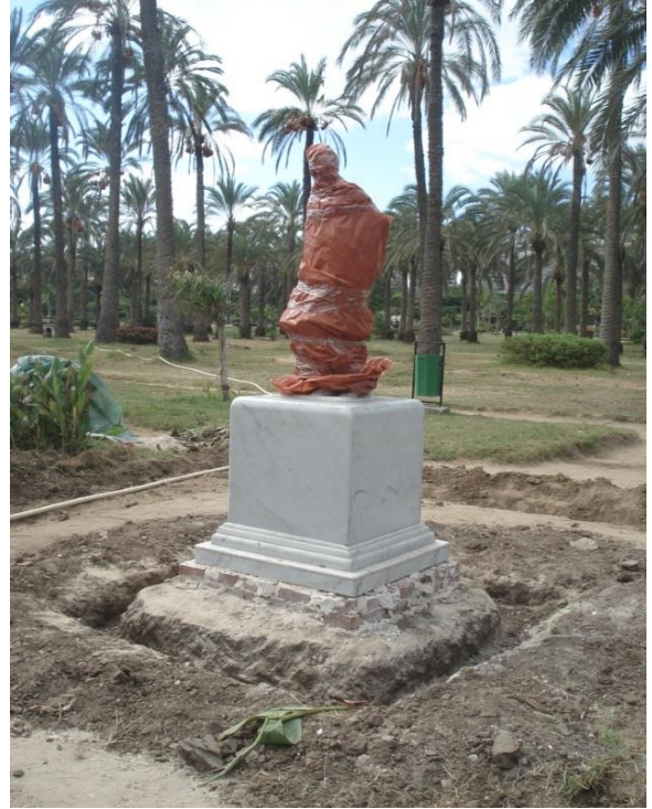
(شكل ١٣) أعمال الحفر حول قاعدة التمثال و تركيب ألواح عزل معدنية و توصيل أعمال الكهرباء و تجاليد الرخام
