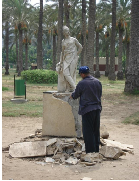
(شكل ١١ - أ ) أعمال ازالة التجاليد الرخامية القديمة
