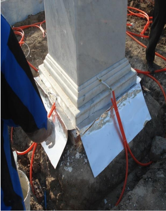
(شكل ١٣) أعمال الحفر حول قاعدة التمثال و تركيب ألواح عزل معدنية و توصيل أعمال الكهرباء و تجاليد الرخام
