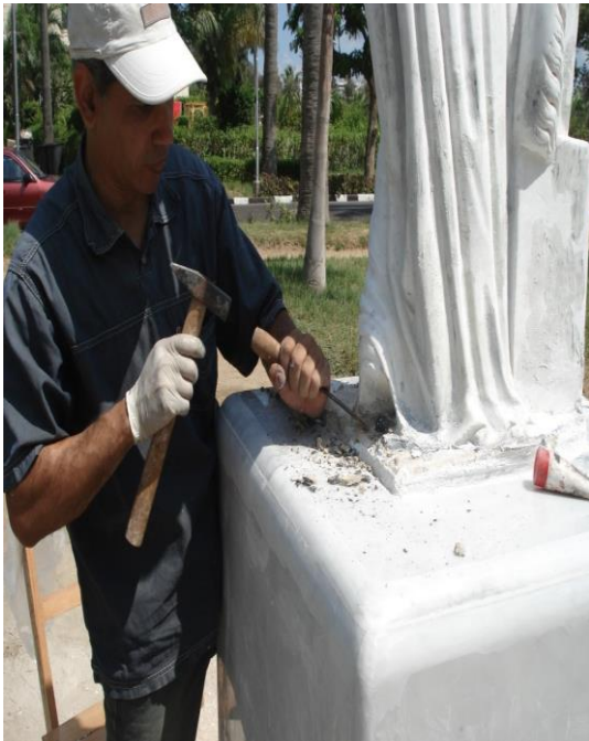
(شكل ١٢ ) ازالة آثار الترميم السابق
